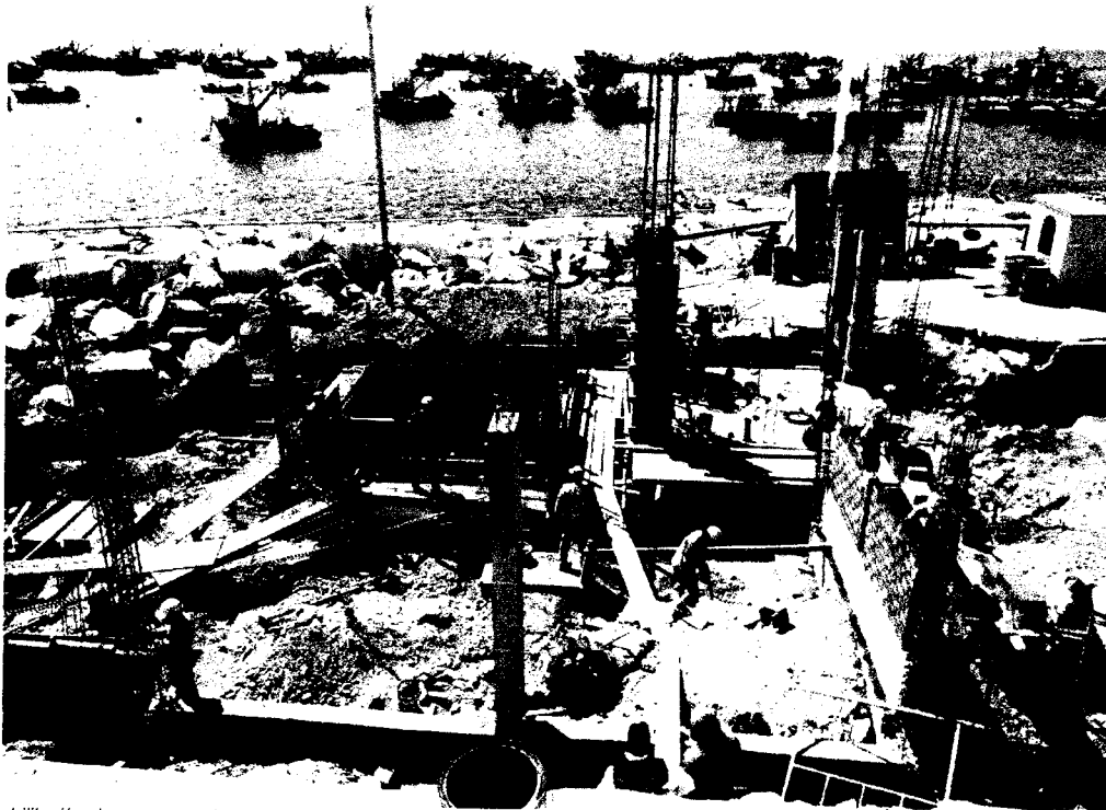
Fig. 03 Habilitación de acero, en vigas de cimentación, sobre cimiento armado, asentado de ladrillos kk de 18 huecos para muro de soga en el bloque de talleres
